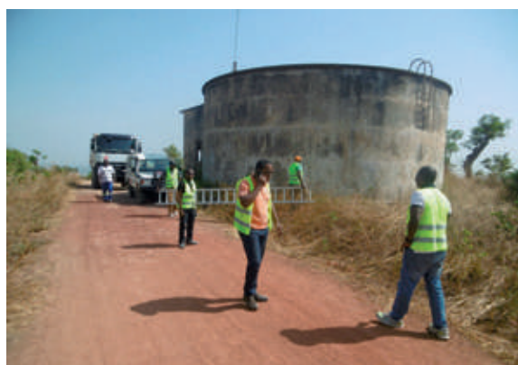
Visite de terrain sur un des réservoirs secondaires de Bouar - ©OiEau
