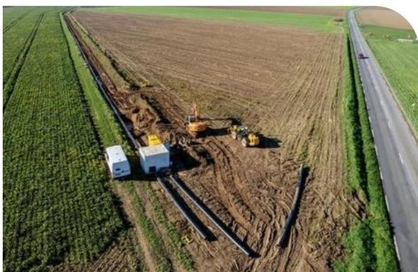
Réalisation du réseau d'irrigation des champs de betteraves d'une sucrerie en Seine Maritime : 2 400 ml en PE100 DN355 PN25 - Raccords électro-soudables PLASSON et soudure bout-à-bout.
