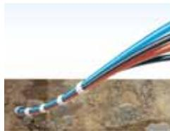
Pose de tubes en faisceau comprenant conduites eau potable et eaux usées dans une même fouille
