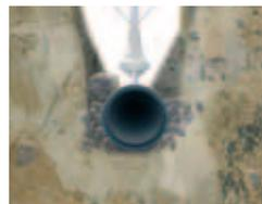
Pose en tranchée ouverte avec ré-emploi des matériaux extraits, ou pose mécanisée avec trancheuse ou soc
