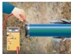
Vérification de l'intégrité complète après la pose et localisation ultérieure possible en x, y et z
