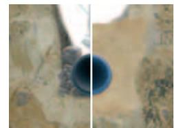
Pose en tranchée ouverte avec ré-emploi des matériaux, ou pose mécanisée avec trancheuse ou soc | pose en tranchée ouverte avec lit de sable
