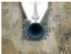
Pose en tranchée ouverte avec réemploi des matériaux, ou pose mécanisée avec trancheuse ou soc
