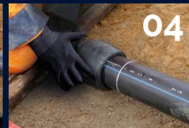
04 Emboîter le tube jusqu'à l'indicateur d'insertion
