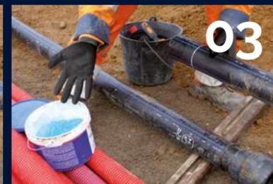
03 Lubrifier le joint d'étanchéité
