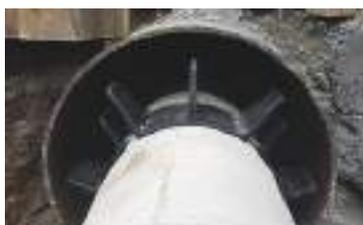
Les colliers de centrage AZ/AC sont composés de plusieurs segments assemblés par boulonnerie zinguée.
