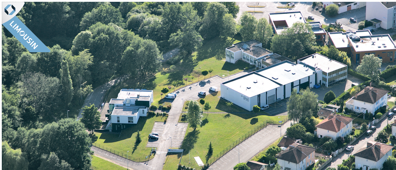
Nos installations à Limoges
